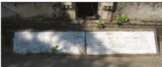
Plăcile de marmură au fost distruse și riscă să dispară, dacă nu se iau măsuri urgente pentru repararea lor.
