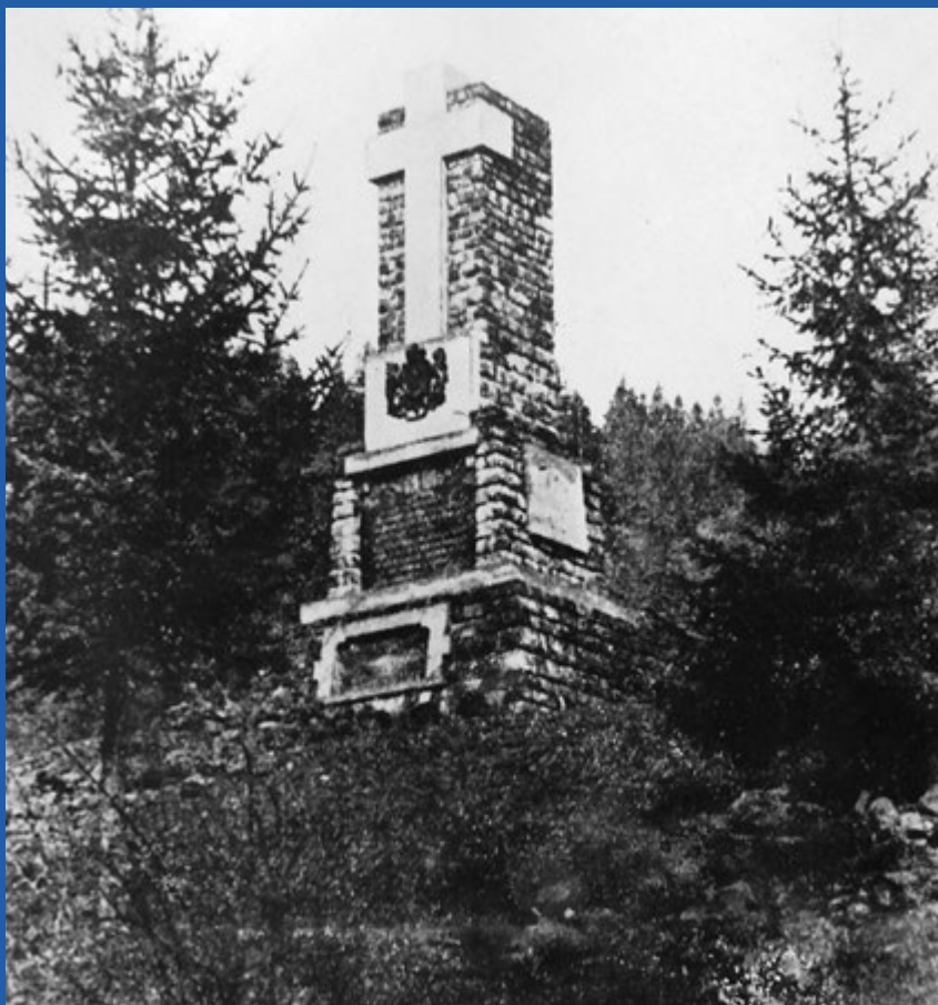
Osuarul monumental din Toplița. 25 eroi în locașuri individuale. 746 eroi în osuar.
