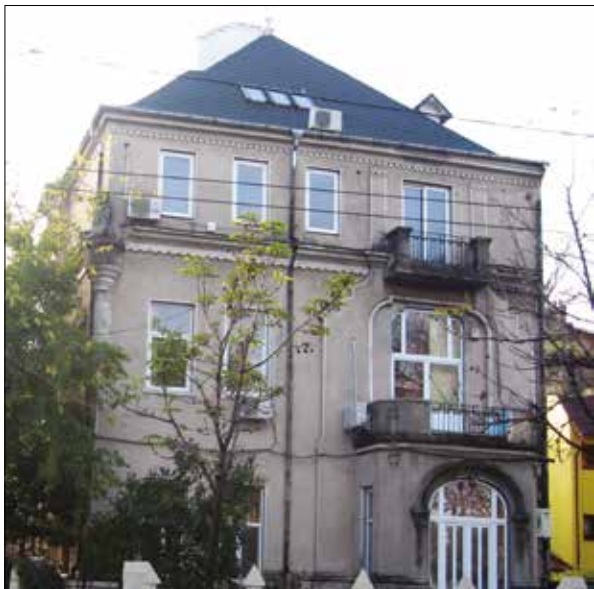
Casa generalului Emanoil Boteanu, în preajma Monumentului Eroilor Sanitari, din București. Casa mai păstrează, prin cine știe ce minune, blazonul familiei (stg. Sus)
